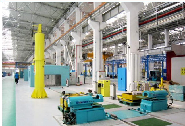
图 36：大功率机车检修基地
